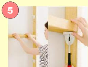
棚板を設置した棚受けの上のせ、下から付属のねじで留め付けます。
